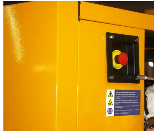
Abbildung 45- Einbau des Not-Aus-Tasters
