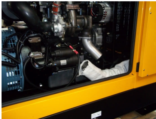
Abbildung 40- Detailansicht der zu verbindenden Schlauchleitung und des Rohrkrümmers.
